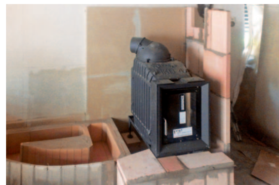
THERMAX® SN 400 Platten als Vormauerung verarbeitet.
