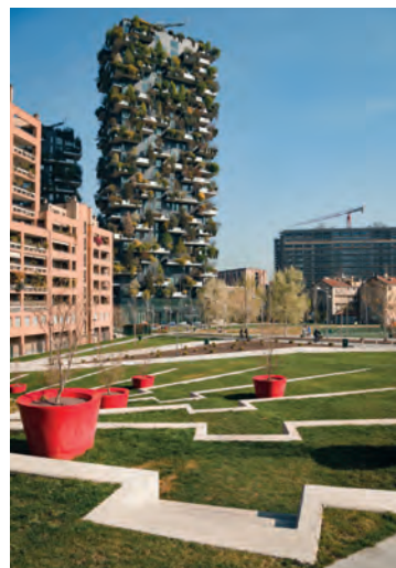
Bosco Verticale in Mailand – Brandschutz mit THERMAX®
